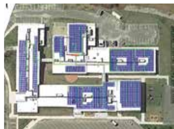
Verifica della configurazione dell'impianto prima dell'installazione
